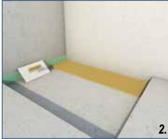
**DE** Vorbereitung des Untergrundes (gerade Fläche), Klebermörtelauf Untergrund auftragen
