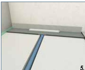
**DE** Trittschall- und Wärmedämmung einlegen
