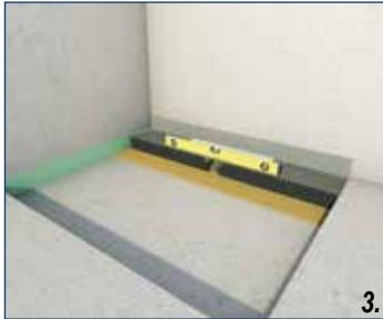
**DE** Duschrinne in den Klebermörtel und an die Wand setzen und waagrecht einnivellieren
