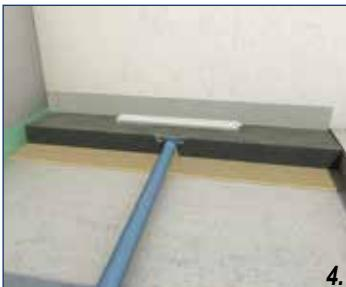
**DE** Ablauf anschließen, Dichtheitsprüfung
