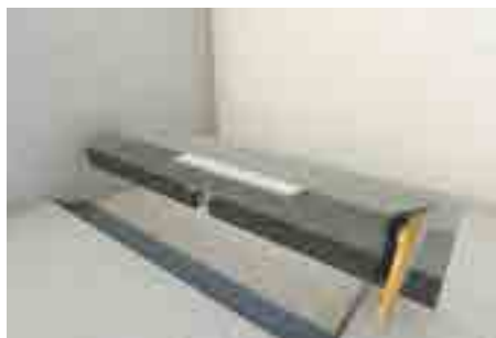
1. Vyměřit prostor pro uložení žlabu; sprchový žlab symetricky a délkově upravit
