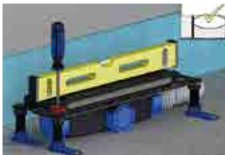
2. Těleso vtoku sprchového žlabu výškově urovnat, v podélném i příčném směru uložit do roviny
