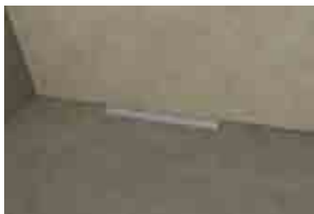
10. Vyjmout ochrannou stavební zátku, silikonem dotěsnit spáru mezi rámem žlabu a dlažbou
