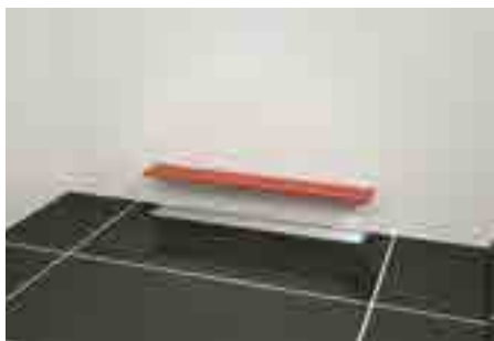
8. Položit a vyspárovat dlažbu (obklady), vyjmout červený ochranný kryt rámu
