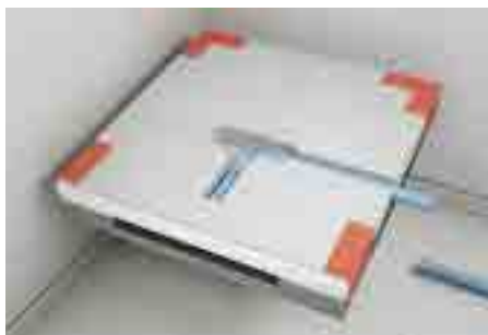
2. Sprchovou desku otočit, vybrat směr odtoku, vyjmout ochranné kryty a napojit odpadní potrubí
