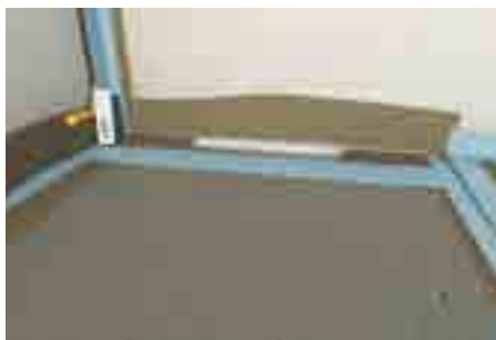
8. Aplikovat těsnicí pásky po obvodu modulu žlabu a prostoru sprchy, utěsnit hydroizolační stěrku celou plochu sprchy
