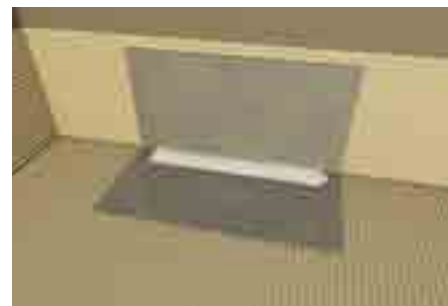
9. Dlažbu položit na doraz k ochranné stavební zátce
