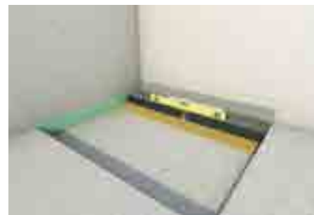
3. Sprchový žlab vlepit ke stěně do stavebního lepidla, popř. nízkoexpanzní PUR pěny a uložit do roviny. Okrajová dilatační páska je součástí tělesa žlabu.
