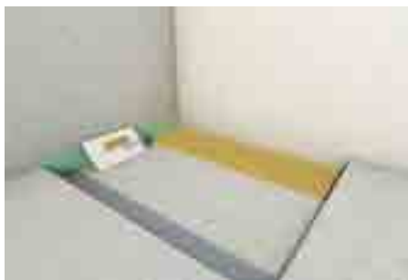
2. Příprava podkladu: očistit a vyrovnat podklad aplikací stavebního lepidla
